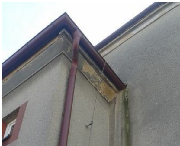
obr. /37/ Na fasádě se nacházejí stopy po zatékání v místě ukončení podokapního žlabu
