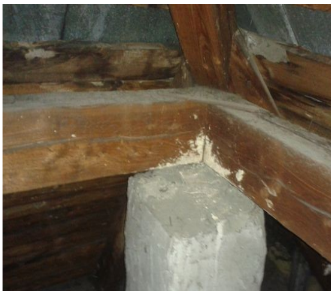
obr. /16/ Nedostatečné kotvení vaznic krovu
