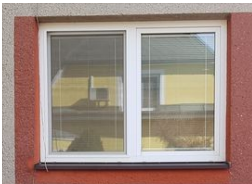
obr. /18/ Plastové dvoukřídlové okno s izolačními dvojskly
