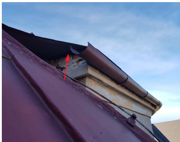
obr. /39/ Čelo podokapního žlabu není vhodně zakončeno, chybí provázání dvou střešních rovin
