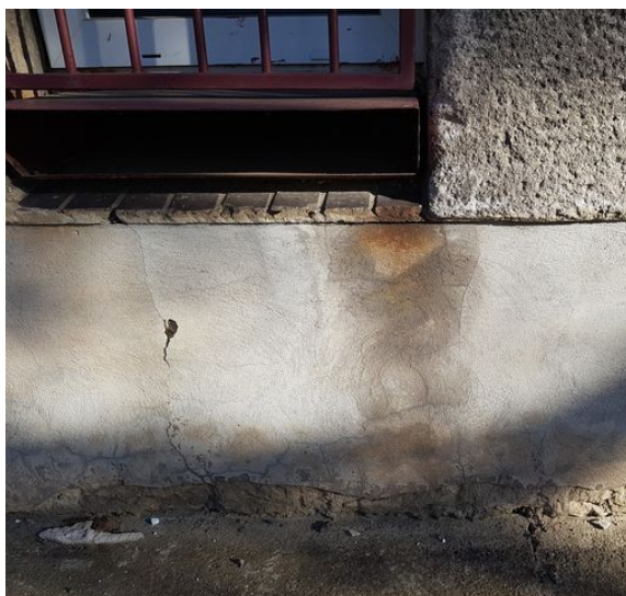
obr. /38/ Obklad parapetu nemá dostatečný přesah a dochází k dotaci fasády vodou
