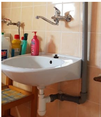
obr. /42/ Pohled na zánovní umyvadlo s pákovou výtokovou armaturou
