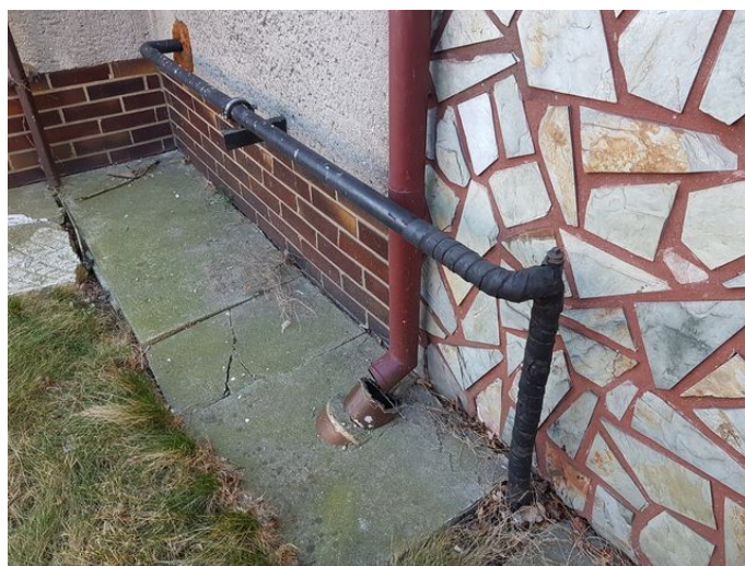
obr. /52/ Napojení plynové přípojky do objektu
