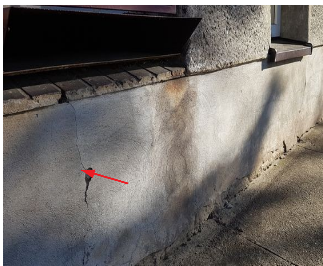
obr. /13/ Trhlina v místě parapetního suterénního zdiva na jižní straně objektu
