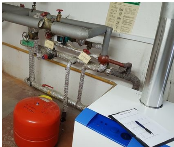
obr. /49/ Otopná tělesa jsou doplněna zánovními termostatickými hlavicemi obr. /50/ Kotelna umístěná v suterénu objektu
