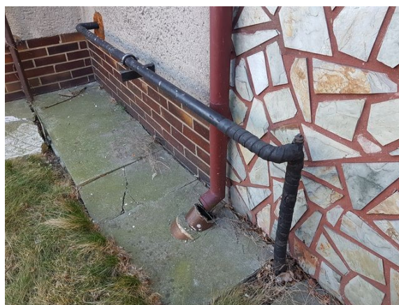
obr. /25/ Mechanicky poškozený okapový chodník
