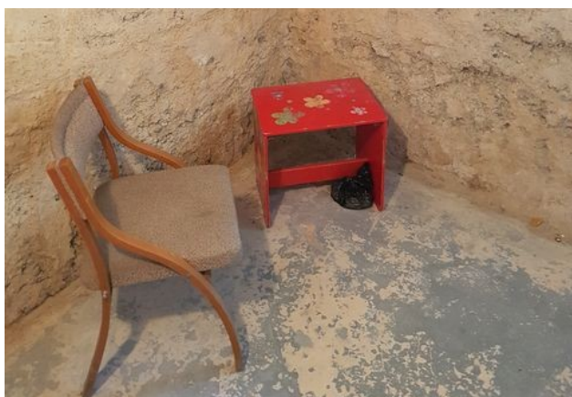
obr. /24/ Nášlapná vrstva technické místnosti je tvořená betonovou mazaninou
