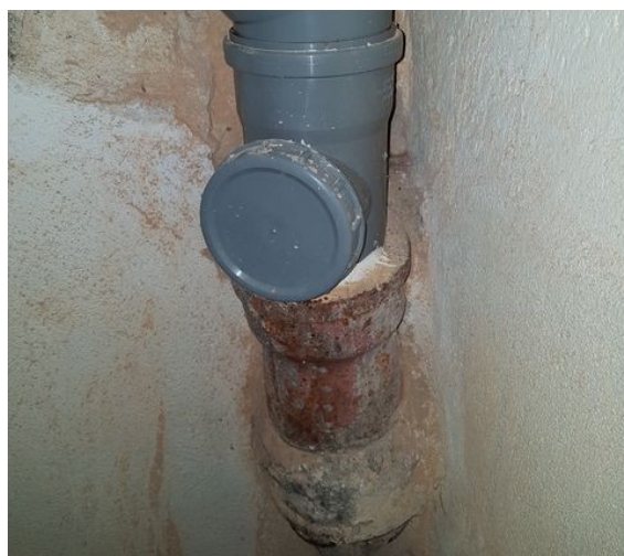
obr. /41/ Zrekonstruovaný vnitřní odpad je napojený na původní kanalizační přípojku
