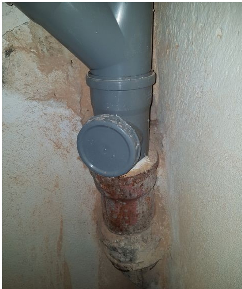
obr. /53/ Napojení odpadního HT potrubí na původní kanalizační potrubí z kameniny
