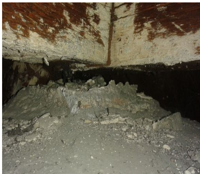
obr. /17/ Uvolnění vaznic od podkladu
