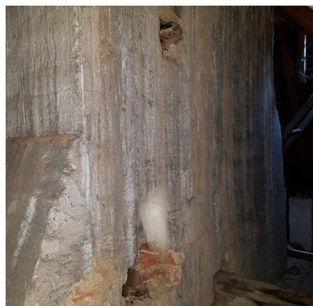
obr. /27/ Na omítce komínového tělesa se nacházejí stopy po zatékání
