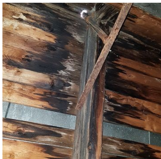
obr. /35/ Stopy zatékání na dřevěném bednění v místě netěsného prostupu přes střešní krytinu
