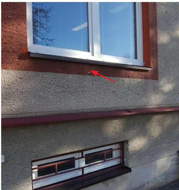
obr. /8/ Pohled na jižní stranu objektu s výskytem trhlin
