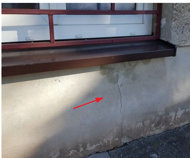
obr. /12/ Trhlina v místě parapetního suterénního zdiva na jižní straně objektu
