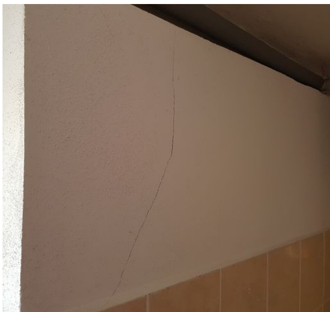
obr. /14/ Trhlina v místě styku stěny a stropní konstrukce
