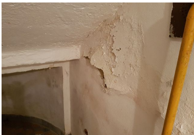
obr. /4/ Západní suterénní stěna je vlhká a vlivem zvýšeného hydrofyzikálního namáhání opadává omítka
