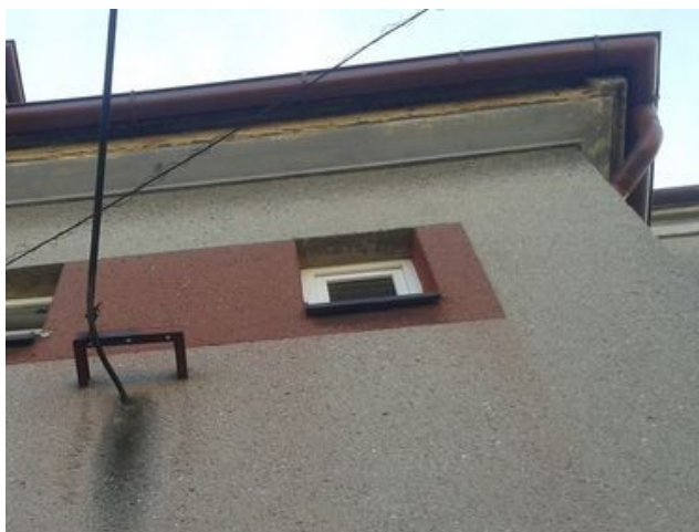
obr. /36/ V místě podokapního žlabu je omítka opadaná pravděpodobně vlivem zamrzání sněhu na okraji střechy v zimním období a následném stékání tající vody po římse objektu
