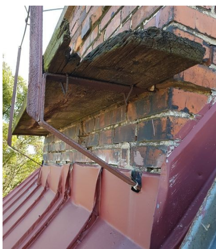
obr. /28/ Revizní lávka komínového tělesa
