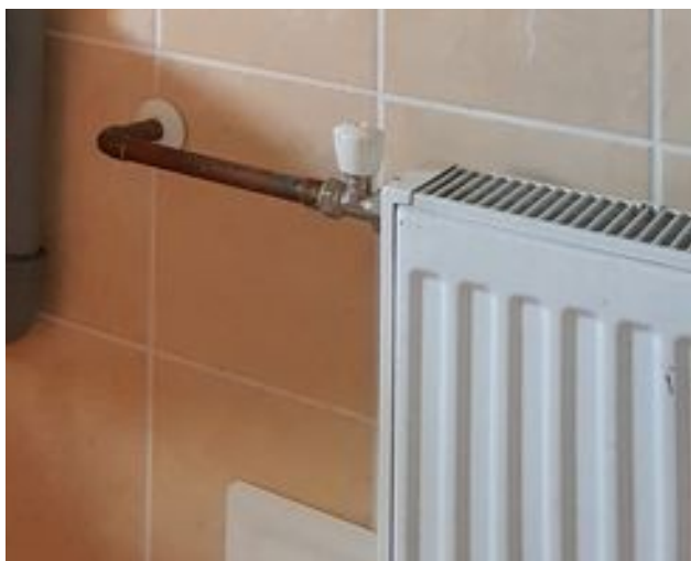
obr. /49/ Otopná tělesa jsou doplněna zánovními termostatickými hlavicemi obr. /50/ Kotelna umístěná v suterénu objektu
