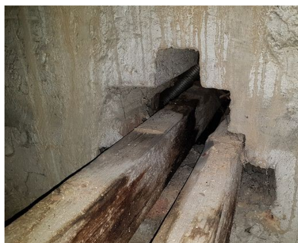
obr. /29/ Přes komínové těleso prochází prvky krovu
