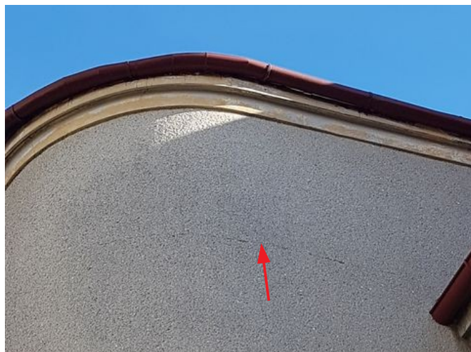
obr. /11/ Detail vodorovné trhliny na schodišťovém zdivu
