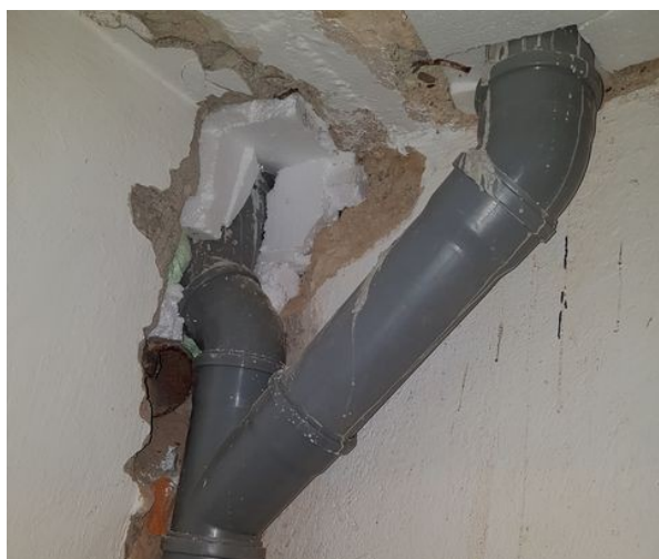
obr. /40/ Po rekonstrukci je odpadní potrubí vedeno v plastu
