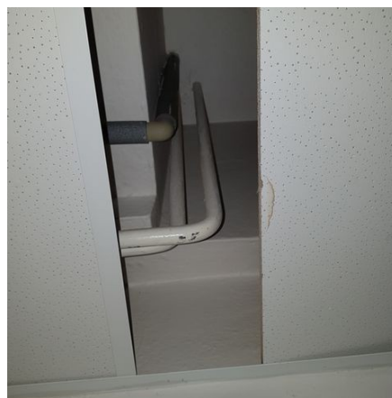
obr. /7/ Na podhledu se nacházejí vlhkostní stopy v místě potrubí
