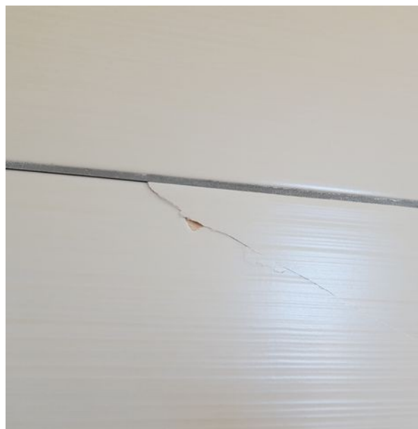
obr. /15/ Trhlina v obkladu v koupelně v podkroví
