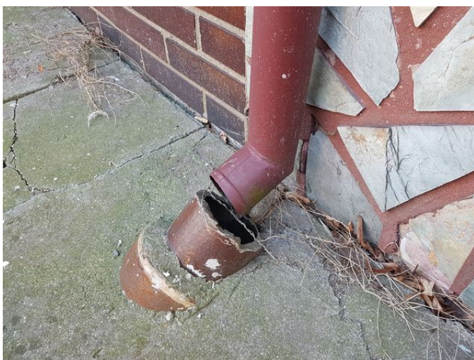
obr. /51/ Netěsné napojení svodu na kanalizační potrubí
